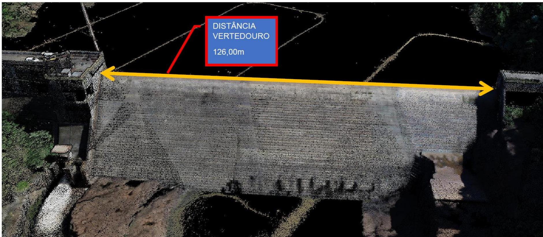
Figura 9 – Barramento – Seção Longitudinal obtida topografia Matrix - 2024
